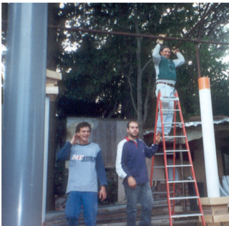
...Giambattista, Salvatore e Giovanni alle prese con il tetto della superba costruzione...
