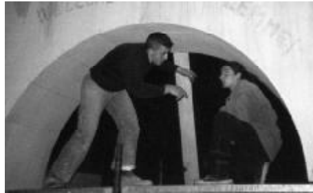
GIOVANNI AMMENDOLIA E MIMMO FORNARO AL MOMENTO DELLA POSA DELL'ARCO
