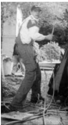
GIANBATTISTA E L'INTERRAMENTO DEI CAVI
