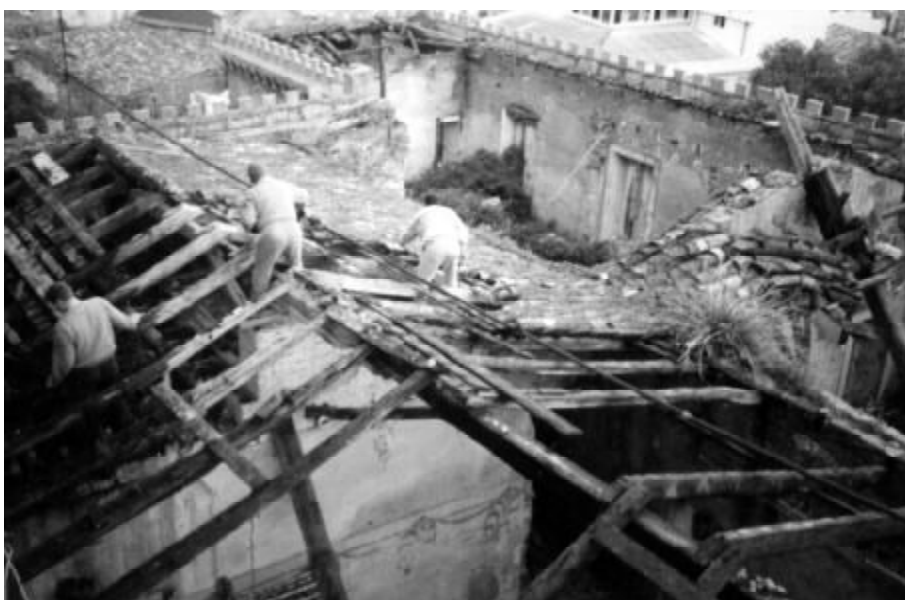
"... l'immane lavoro della copertura ..."
