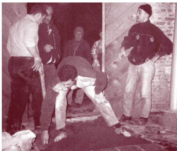
... la posa del pavimento ...
